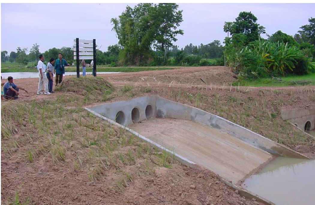
รูปที่ 2.4 แสดงอาคารระบายน้ำ
