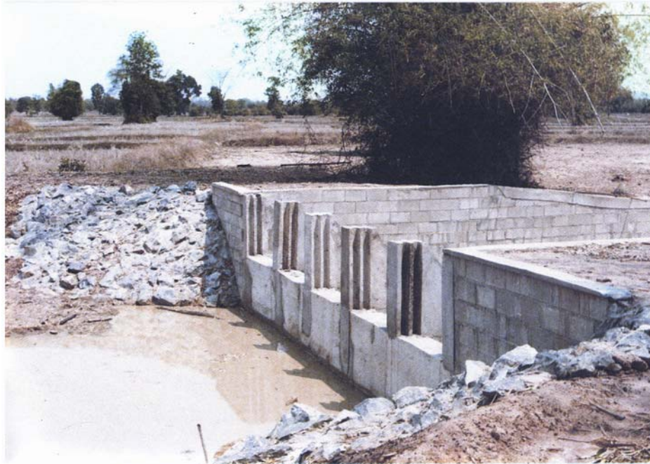
รูปที่ 2.7 แสดงฝายทดน้ำขนาดเล็ก (ฝายมาตรฐาน มข.2527)
