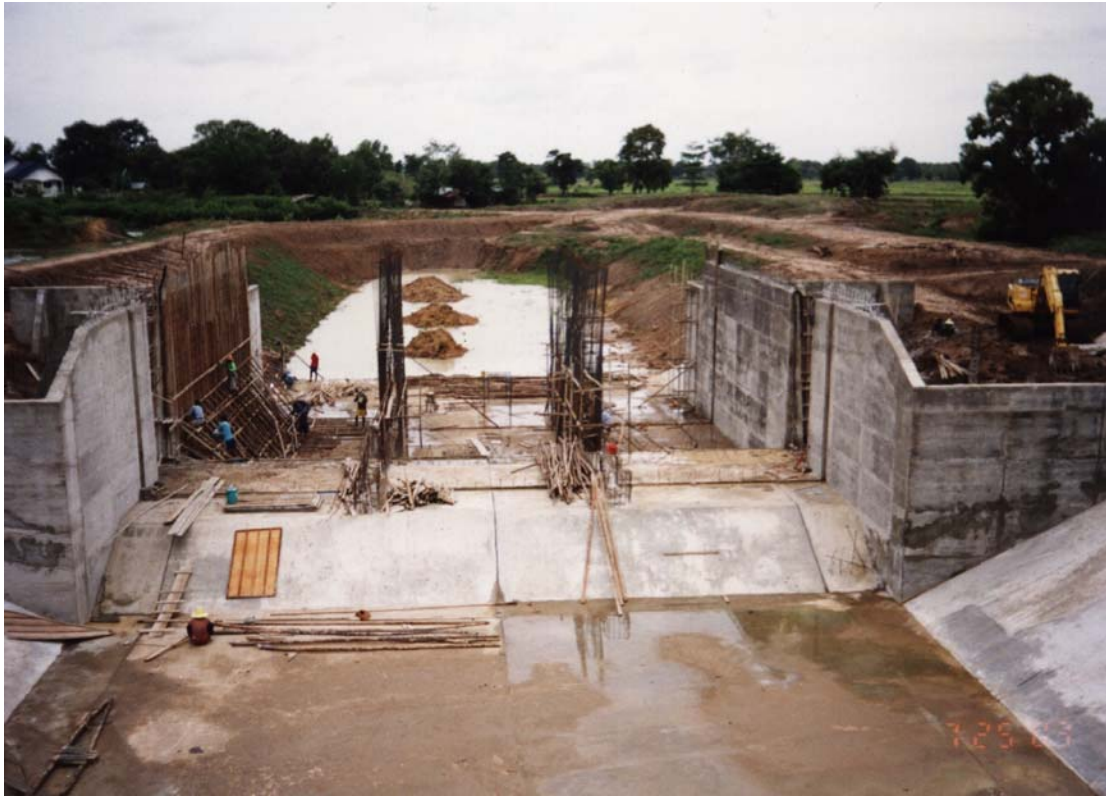
รูปภาพแสดงโครงการสร้างการเสริมเหล็กฝาย มข.
